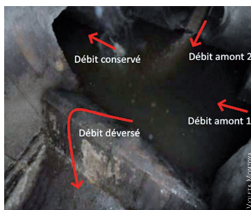
Schéma de fonctionnement d'un déversoir d'orage à Figeac, étudié par Violeta Montoya
